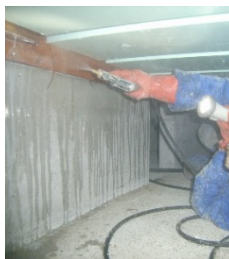
防蟻・防腐処理
